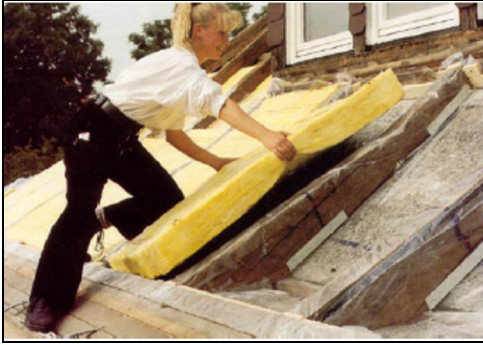
Bild 16: Zwischensparrendämmung von der Dachseite
