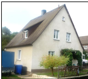
Bild 22: Einfamilienhaus 50 / 60 er Jahre
