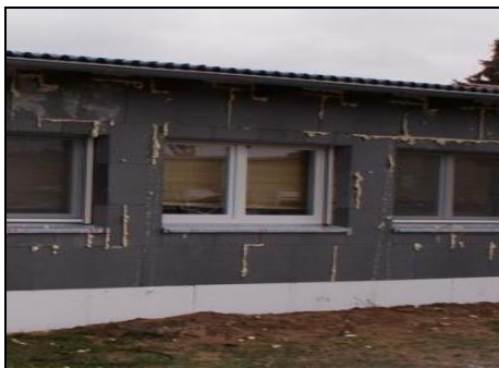
Bild 7: Sockelbereich gedämmt
