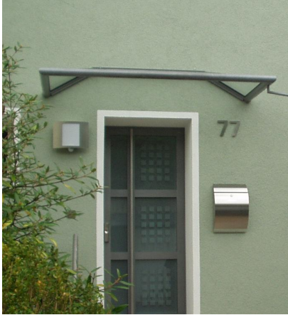
Bild 9: neue Haustür und neues Vordach
