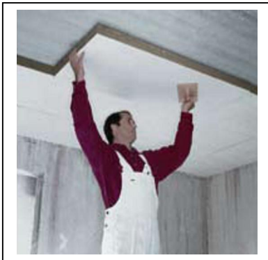
Bild 11: Dämmung der Kellerdecke
