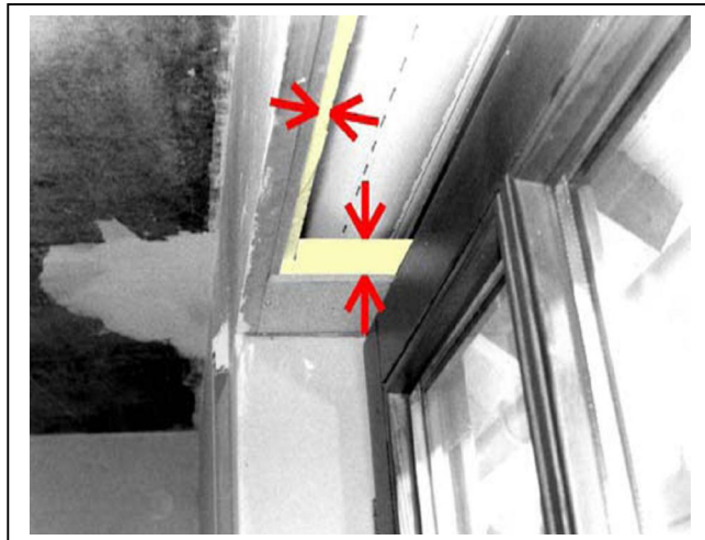
Bild 13: Dämmung des Rollladenkastens
