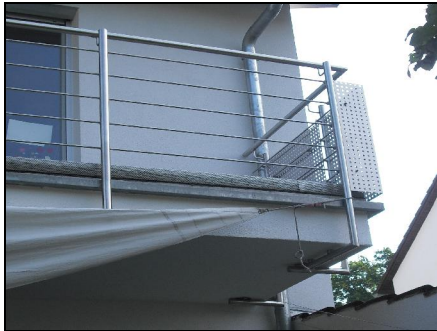
Bild 4: Vordach unterseitig gedämmt
