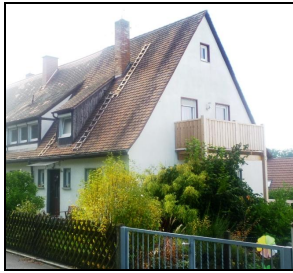
Bild 23: Doppelhaushälfte 50 / 60er Jahre
