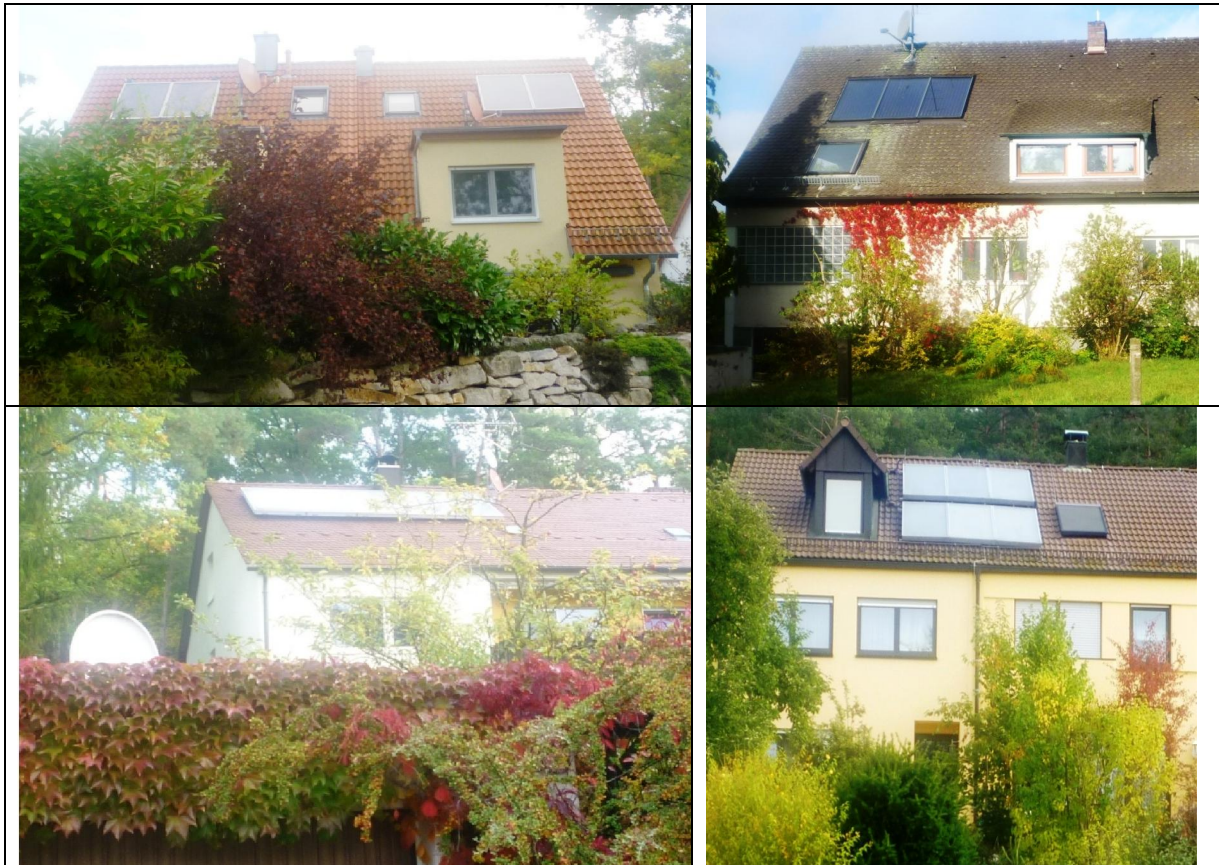
Bild 18 - 21: Solarthermieanlagen im Untersuchungsgebiet
