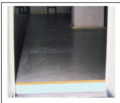
Bild 14: Dämmung des unbeheizten Dachboden
