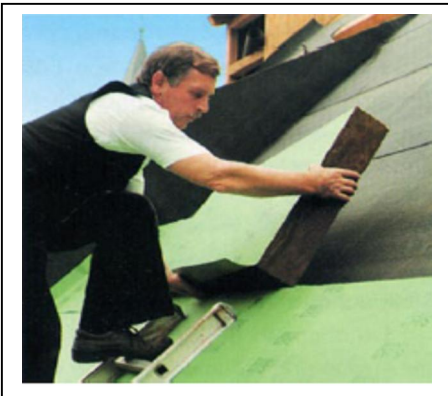
Bild 17: Aufsparrendämmung
