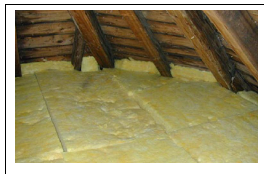
Bild 15: Dämmung des Spitzbodens
